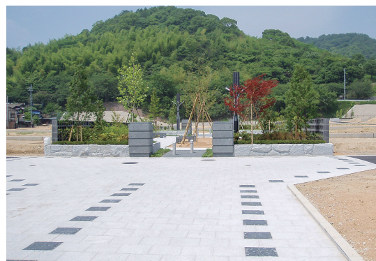
積水ハウス コモンステージ整備工事
