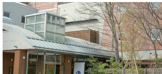
姫彦温泉新築工事
