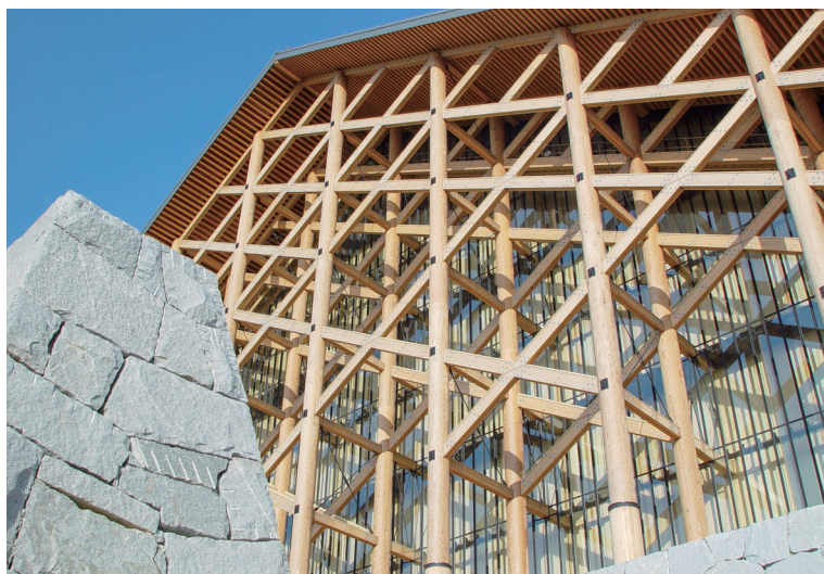
愛媛県武道館石積工事
