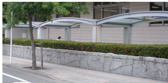
松山大学石積み工事
