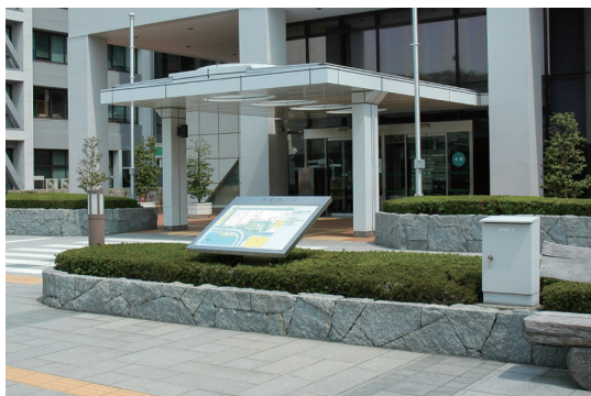
松山市役所石積工事
